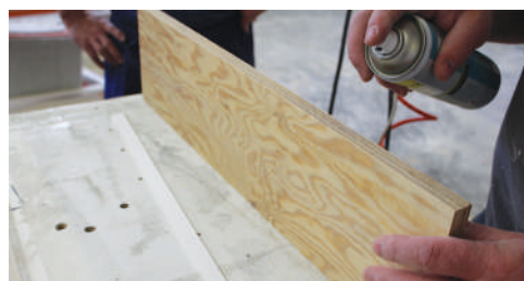
Application de la colle contact REZIFIX sur le chant.
