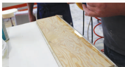
Mettre un scotch pour ne pas mettre de la colle REZIFIX à l'endroit où nous allons coller le V-korr.
